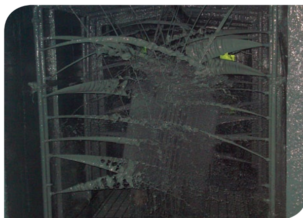
Slika 5: Oblivanje transformatorskega kotla
