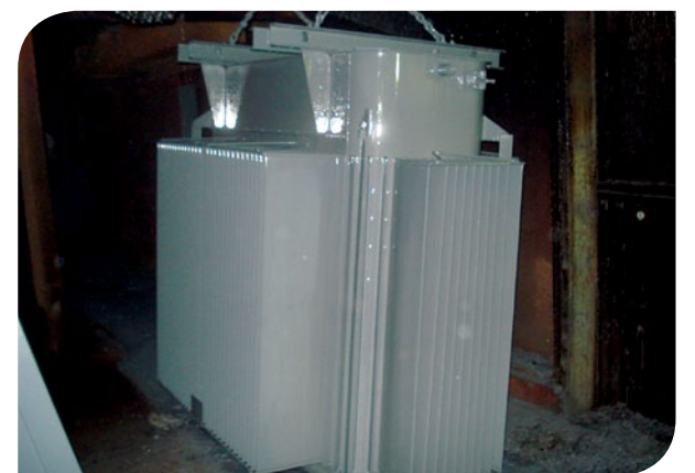
Slika 6: Oblit transformatorski kotel
